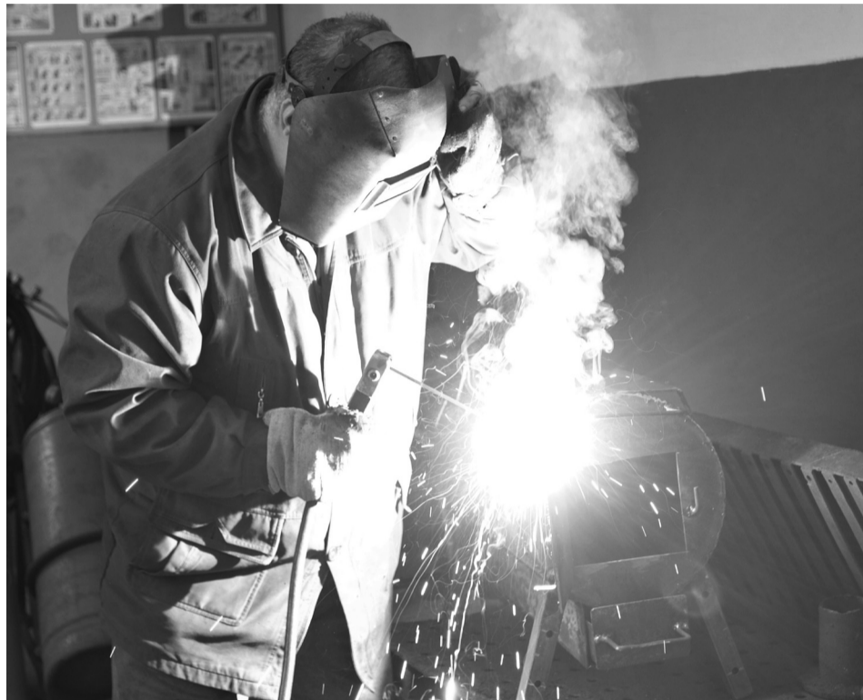
Коли всі комплектуючі готові, Олександр Лічов виконує роботи зі зварювання металу. Фото автора.
