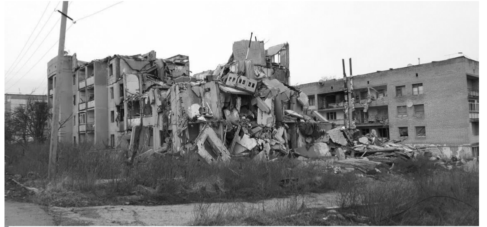
Пошкоджений будинок у с. Мілова.
