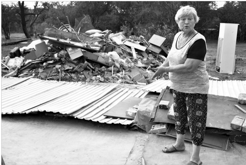
Тамара Бойко вказує на місце, де до російського ракетного удару стояла цегляна будівля літньої кухні.
