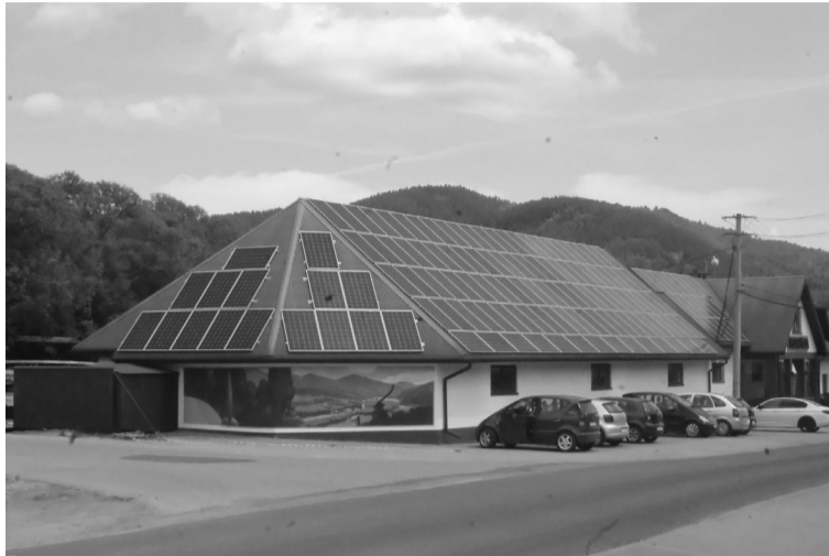
Кожен дах — окрема електростанція.
