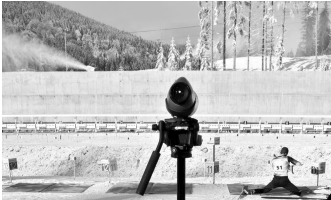
Аби повністю відгородити гірськолижний підйомник від біатлонного стрільбища, бетонний мур має стати вдвічі вищим.
